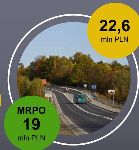
Rozbudowa drogi wojewódzkiej nr 967 na podjazdach pod Górę Borzęką
