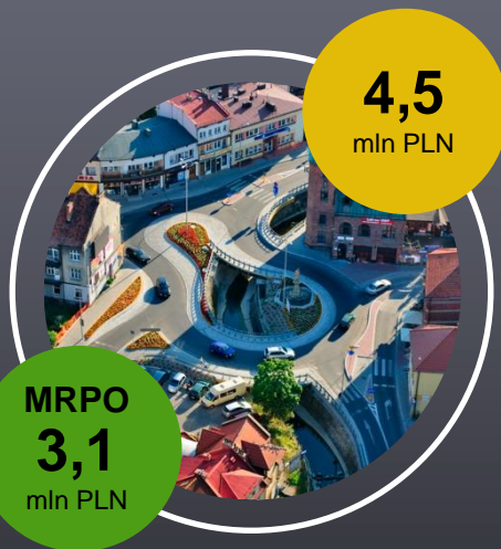
Budowa ronda w Myślenicach
