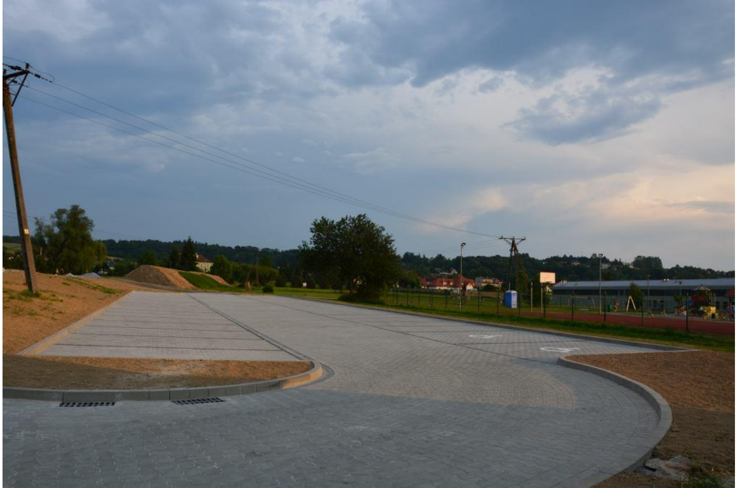
Budowa parkingu przy ulicy Szkolnej.
