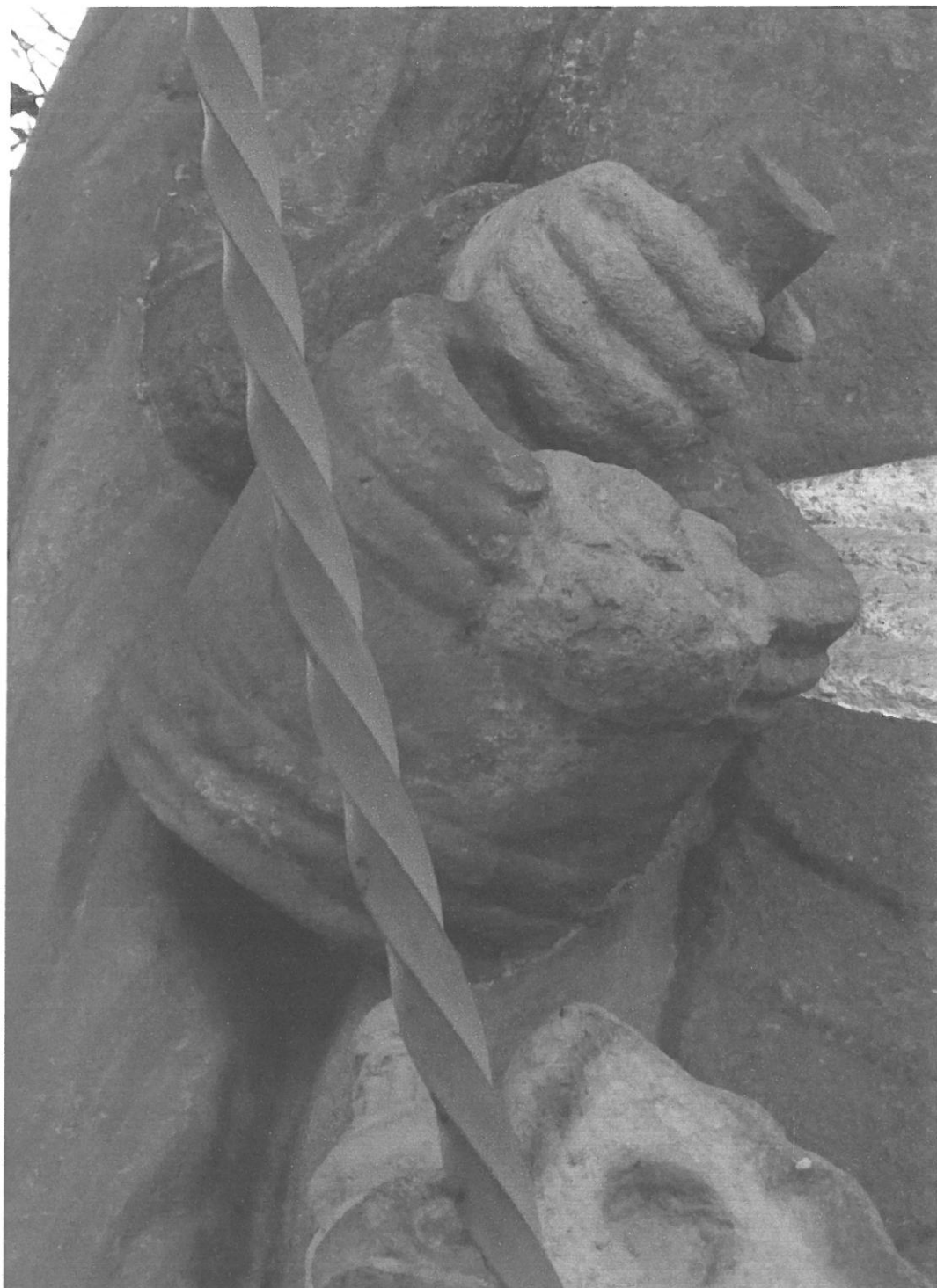
Fot. 10. Kapliczka Św. Floriana w Dobczycach, widok na figurę, widoczne ubytki kamienia i pudrująca się warstwa malarska. Fot. M. Książek 2019r.
