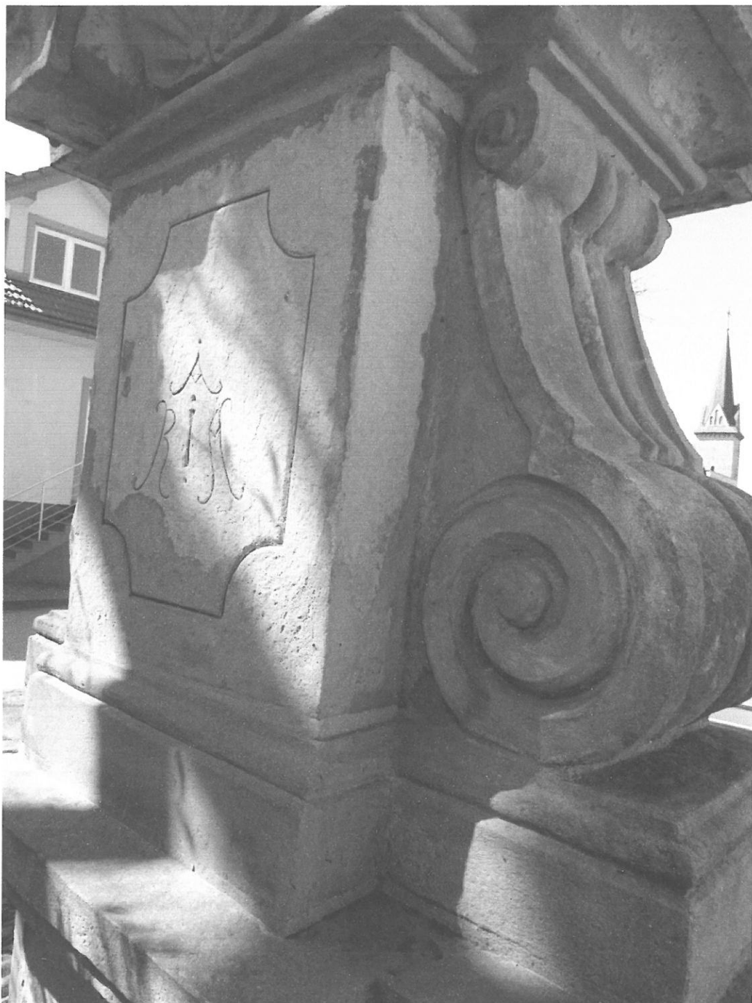
Fot. 8. Kapliczka Św. Floriana w Dobczycach, widok na postument od tyłu, widoczne pociemniałe i zmienione kolorystycznie kity. Fot. M. Książek 2019r.
