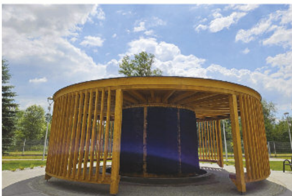
Budowa tężni solankowej
