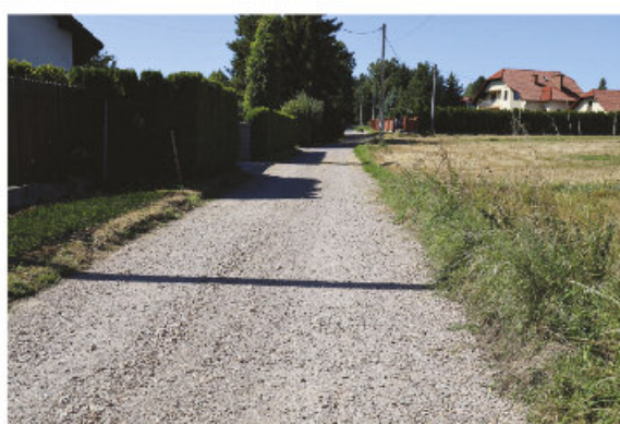
Modernizacja drogi w Kędzierzynie
