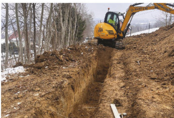
Rozbudowa sieci kanalizacyjnej Skrzynka
