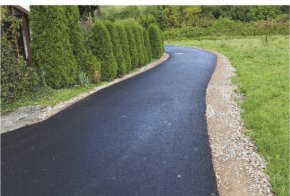
Modernizacja drogi do przysiółka "Koziniec"
