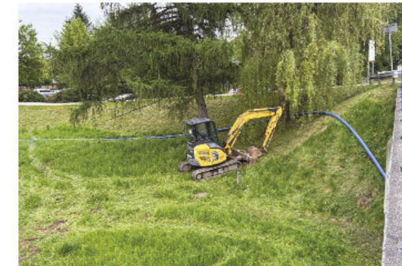
Rozbudowa sieci kanalizacyjnej na ul. Targowej
