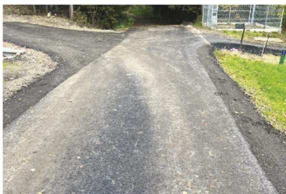
Modernizacja dróg w Brzezowej
