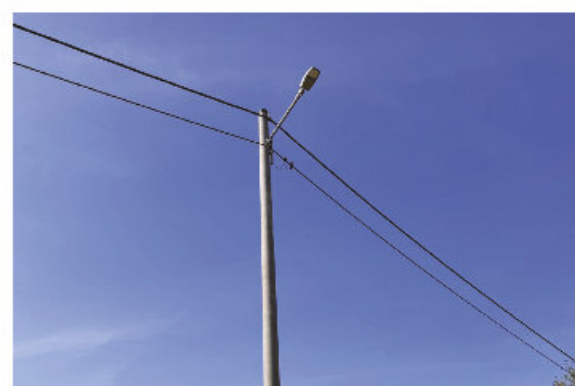
Modernizacja oświetlenia w Dobczycach ul. Grabowa
