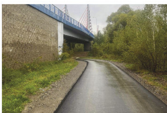
Budowa odcinków Velo Raba na terenie Gminy Dobczyce przez ZDW
