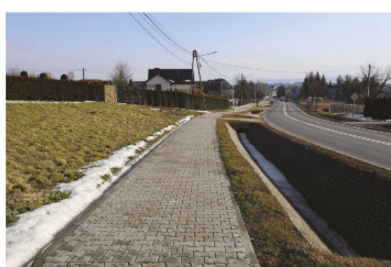
Przebudowa chodnika w miejscowości Sieraków
