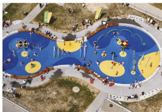
Budowa wodnego placu zabaw
