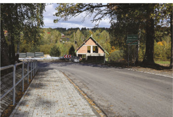
Modernizacja drogi w Nowej Wsi
